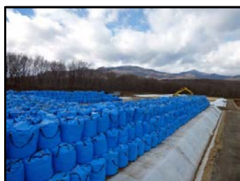
仮置場造成の様子
