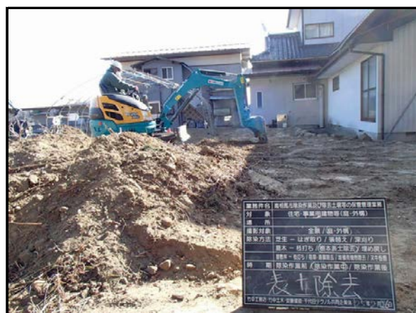
庭除染作業中
