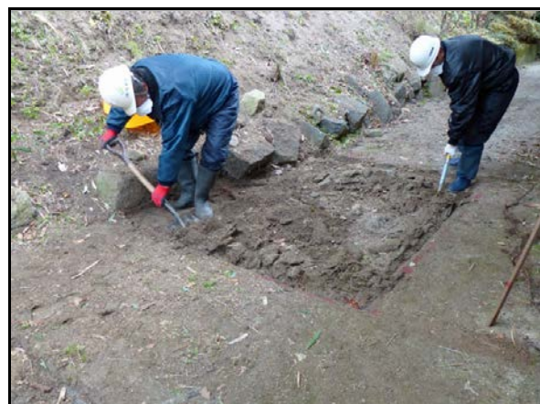
夏井地区除染作業
