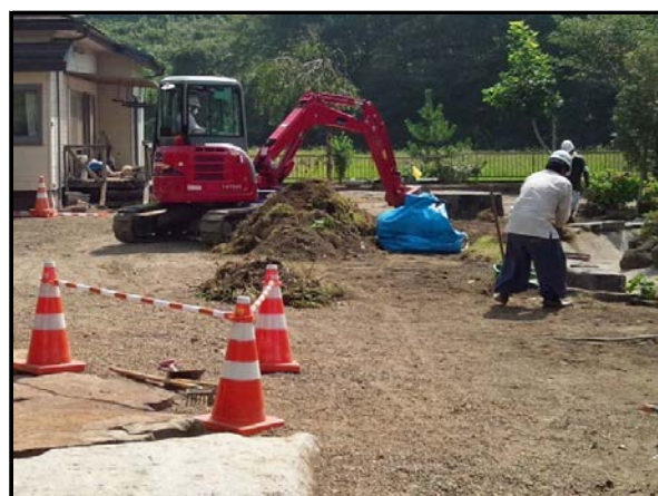
住宅敷地内の除染作業
