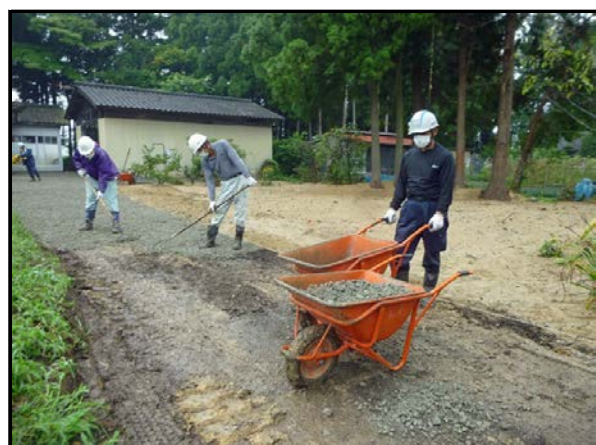
住宅除染実施状況
