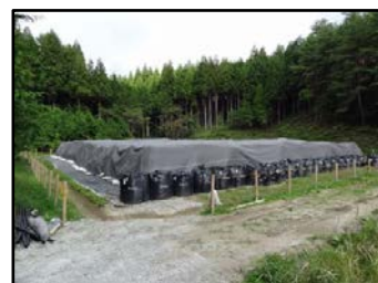
キャッピング完了後
