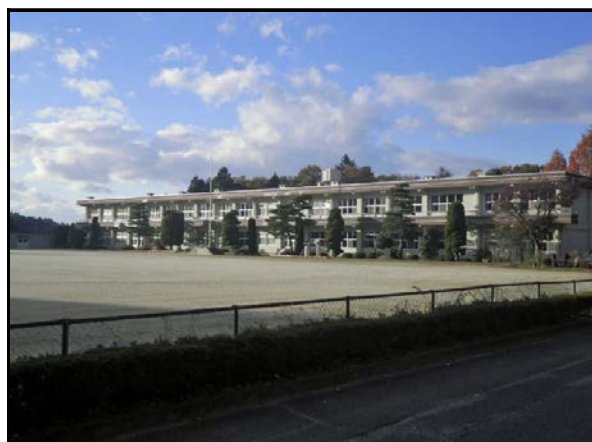
除染現場 (山白石小学校)
