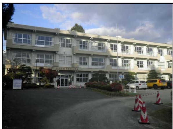
除染現場 (里白石小学校)
