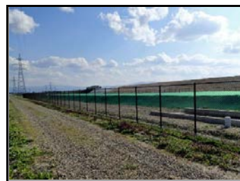
仮置場 保管状況
