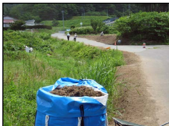
道路除染状況
