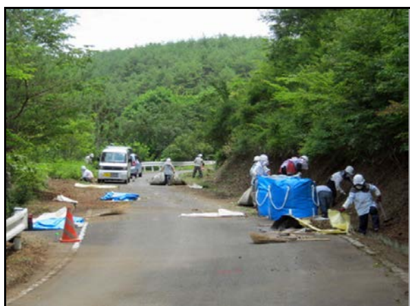
道路除染状況
