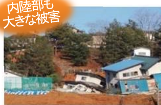
家屋被害の状況（福島市伏拝地区内）
