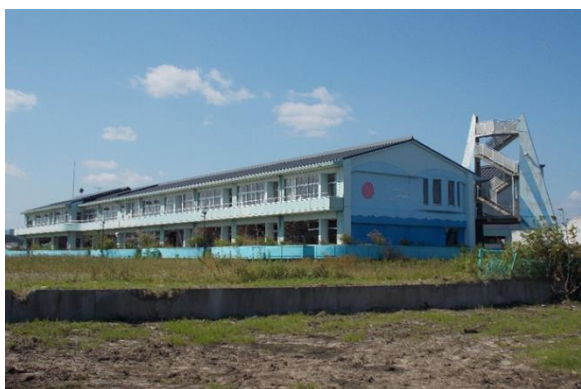
請戸小学校 (平成 27 年 9 月 22 日撮影)
