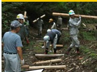
表流水により路面が洗掘されないように、丸太の配置を工夫して、鉄筋杭で固定しました。
