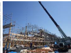
⑤建て方状況
