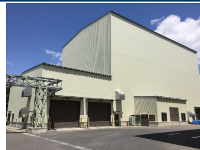
仮設焼却施設
