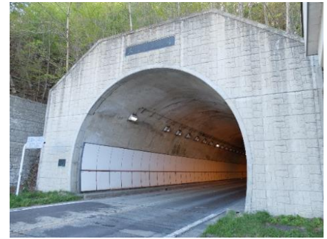
土湯トンネル(猪苗代坑口)
