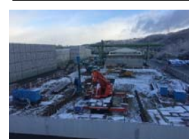
基礎、ピット解体撤去状況
