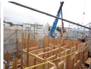
②解体状況
