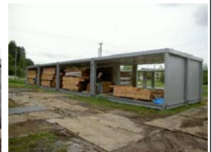
③解体材の保管状況
