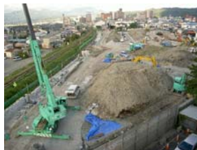
④造成工事の状況
