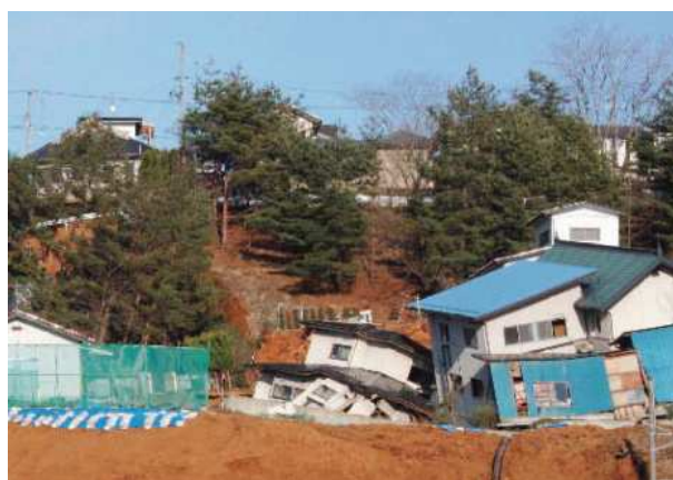
家屋被害の状況(福島市伏拝地内)
