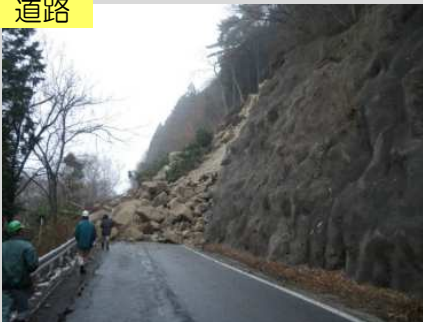
白河羽鳥線の被害状況(3/15)
