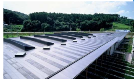
太陽光発電導入事例 (郡山市・福島県農業総合センター)
