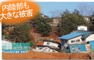
家屋被害の状況（福島市伏拝地内）
