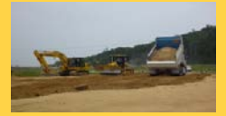
浅見川防災緑地整備
