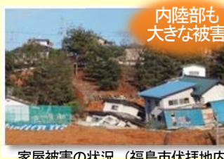
家屋被害の状況（福島市伏拝地内）
