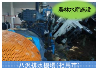
八沢排水機場（相馬市）
