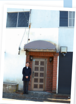
汐風竹町通りにある空き店舗をリノベーション中
