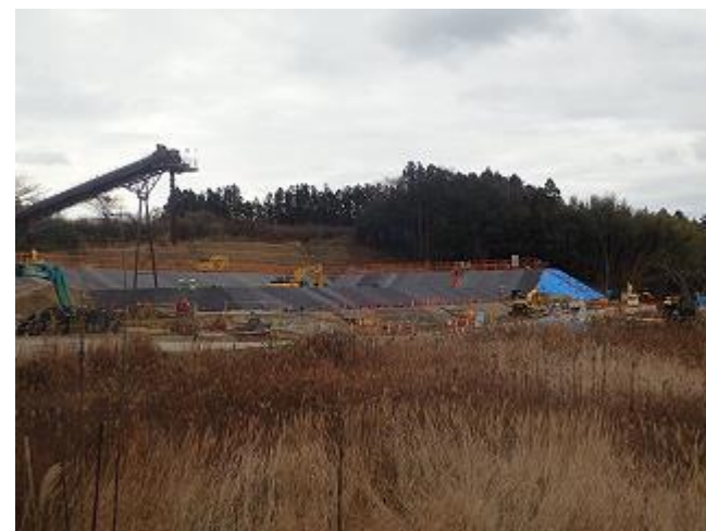
土堰堤等の設置状況の確認
