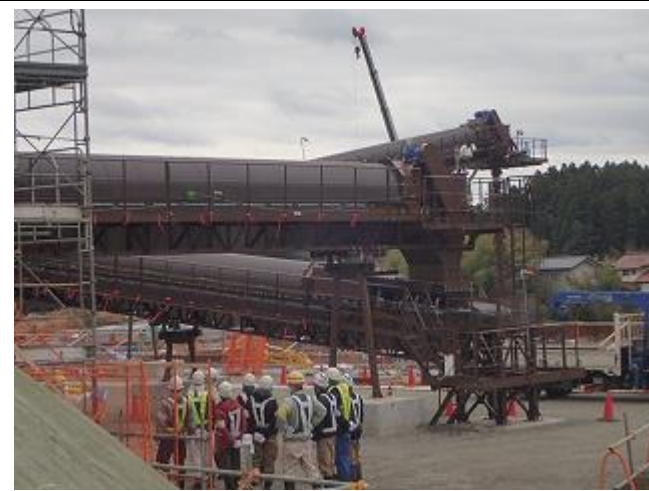
ベルトコンベアの設置状況の確認
