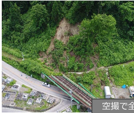
<H29.7.19 国道252号> [法面崩壊により土砂流出]
