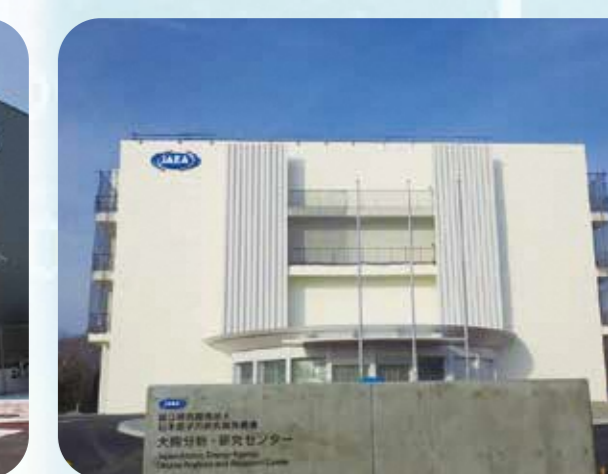
大熊分析・研究センター施設管理棟
