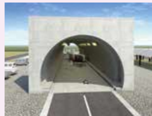
インフラ点検・災害対応エリア (試験用トンネル)
