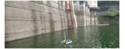
水中ロボットによるダム堤体の調査試験の様子
