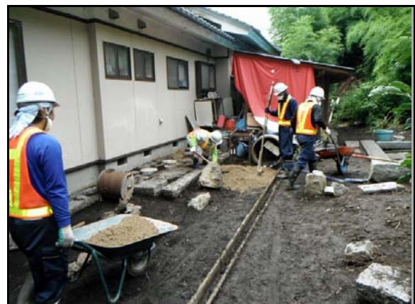
住宅除染実施状況
