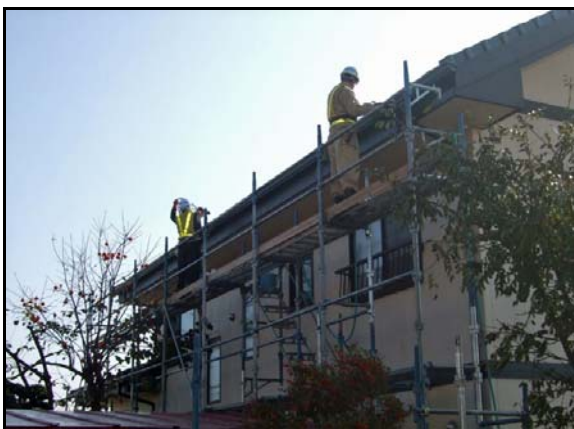
住宅除染実施状況
