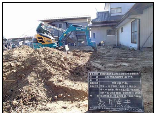
庭除染作業中
