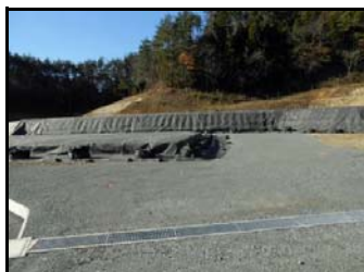
仮置場保管状況
