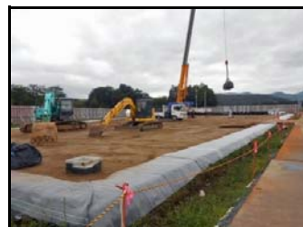
仮置場造成・搬入状況
