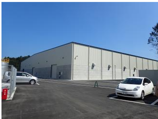
大熊町仮設焼却施設の稼働状況の確認
