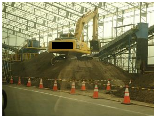
受入・分別施設の稼働状況の確認
