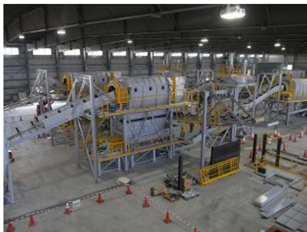
受入・分別施設の設置状況の確認
