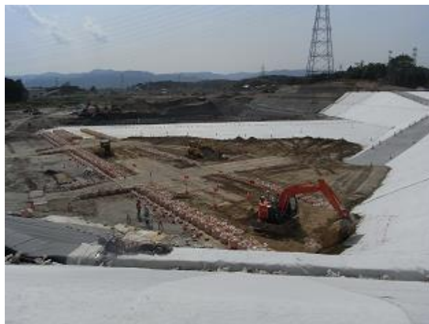
土壌貯蔵施設の設置状況の確認
