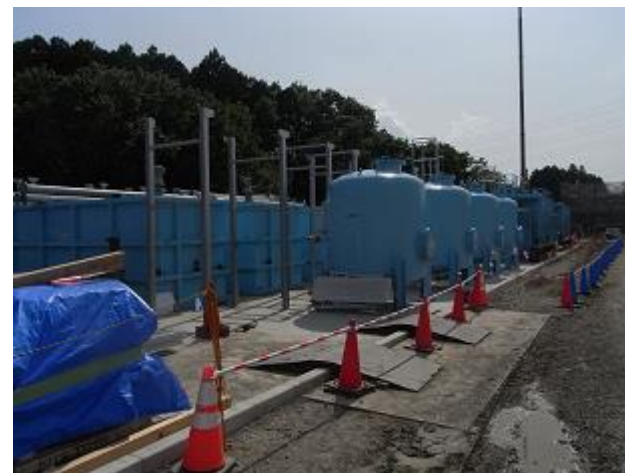
浸出水処理施設の設置状況の確認
