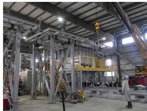
受入・分別施設の設置状況の確認
