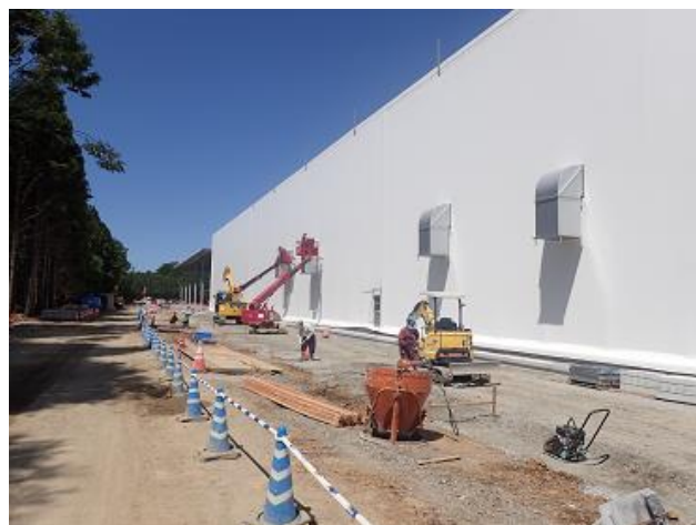
受入・分別施設の設置状況の確認
