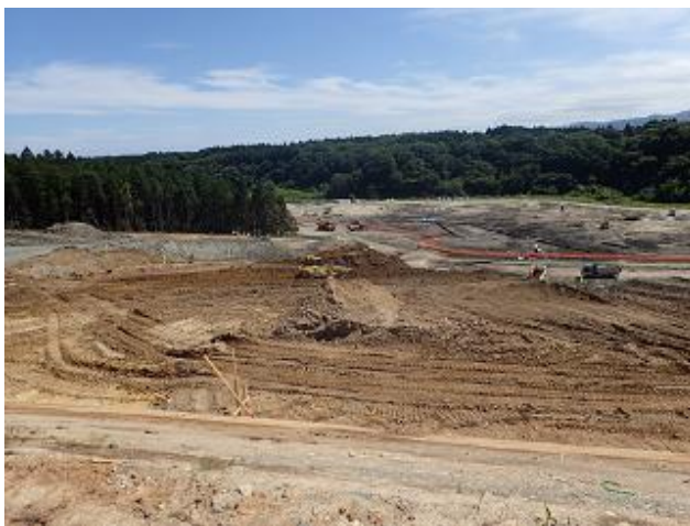
土壌貯蔵施設の設置状況の確認
