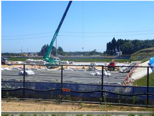
土壌貯蔵施設の設置状況の確認
