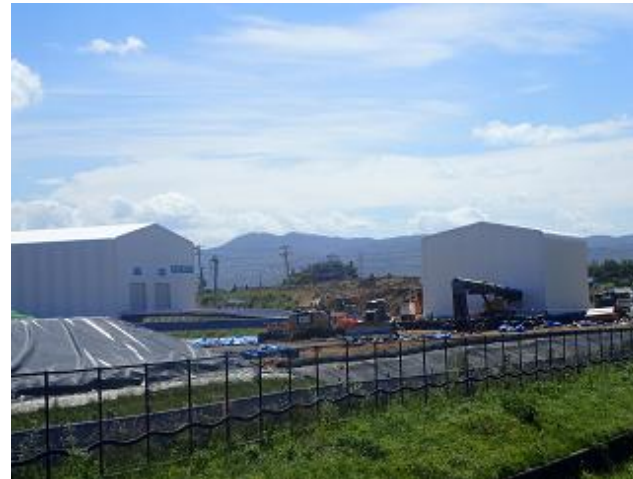
土壌貯蔵施設の稼働状況の確認
