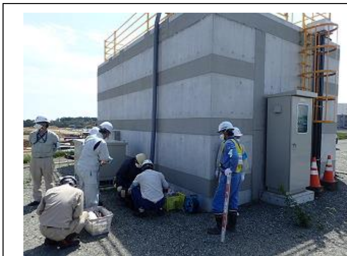
土壌貯蔵施設におけるシート下部湧水の測定
