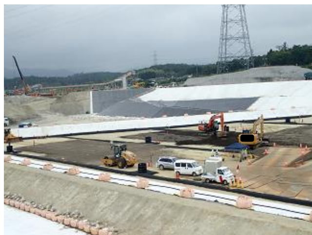
土壌貯蔵施設の設置状況の確認
