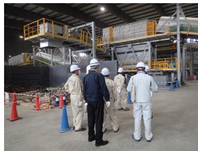
受入・分別施設の稼働状況の確認
