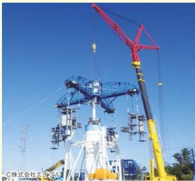
排気筒解体装置の吊り込みの様子
