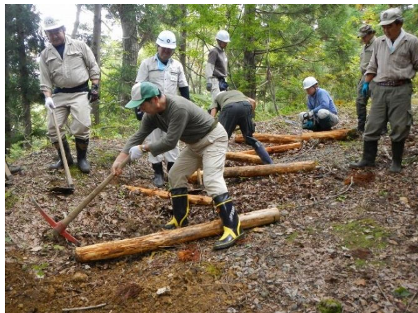
美女峠(三島) 人力による現地間伐材を用いた作業
