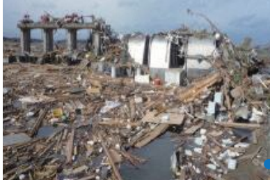
○ P7 大戸浜排水機場（新地町）
