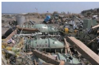
津波で建屋が流失（大戸浜排水機場）
