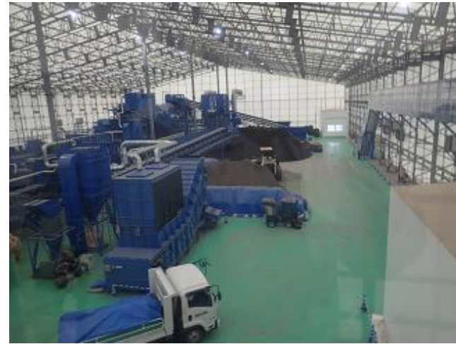
受入・分別施設の稼働状況の確認
