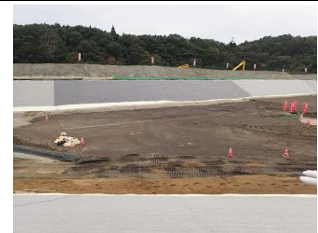
土壌貯蔵施設への除去土壌の搬入状況の確認
