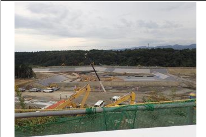
土壌貯蔵施設の設置状況の確認
