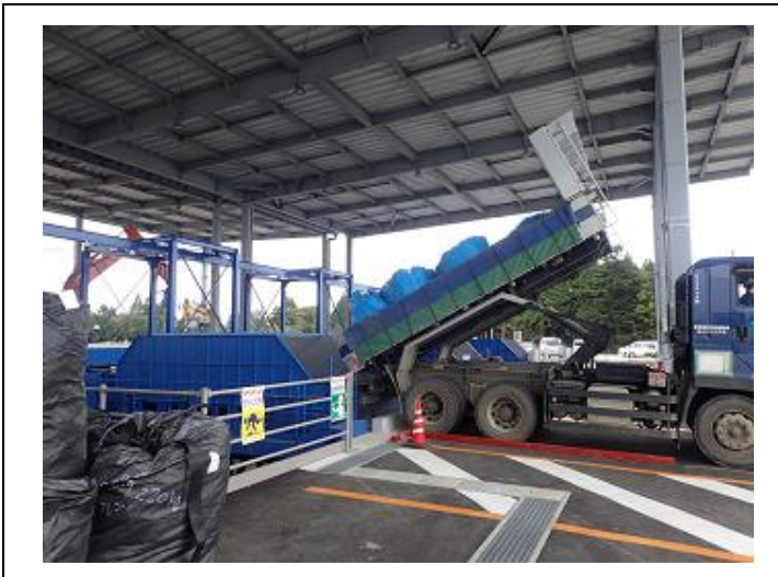
除去土壌の搬入状況の確認
