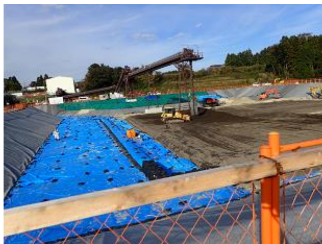
土壌貯蔵施設の稼働状況の確認
