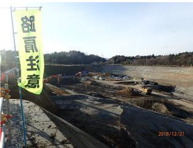
土壌貯蔵施設の設置状況の確認
