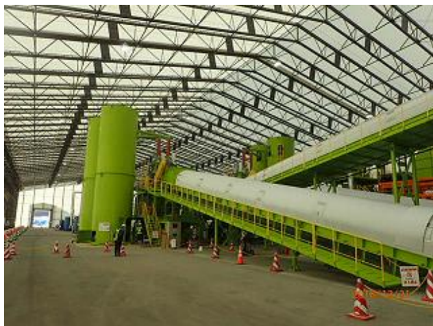
受入・分別施設の設置状況の確認
