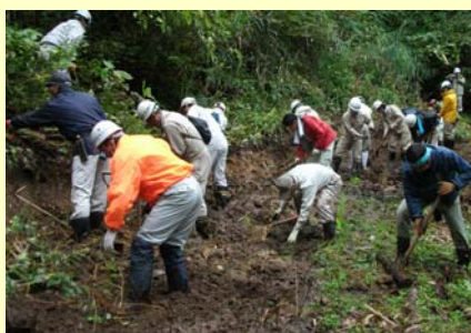
ぬかるみに足を取られながら、みんなで土側溝を掘り進めました。
