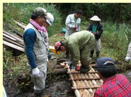
栈橋を作り、すべらないように丸太に角材を取り付けました。
