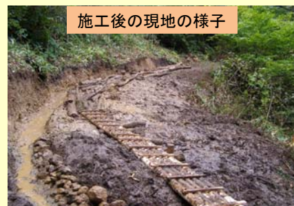
土側溝に水が集中して流れ、排水効果が期待できるようになりました。
