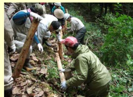
丸太を組んで番線で結束し、土留工を施工しました。
