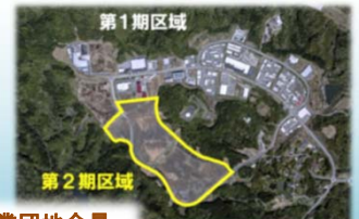
工業団地全景
