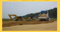
浅見川防災緑地整備
