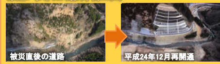
県道いわき石川線(才鉢工区)
