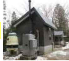
薪ボイラー & 冷温水発生器導入
