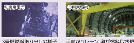
3号機燃料取り出しの様子 手前がクレーン 奥が燃料取扱機
