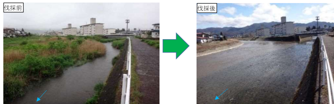
土砂掘削・伐採 イメージ
