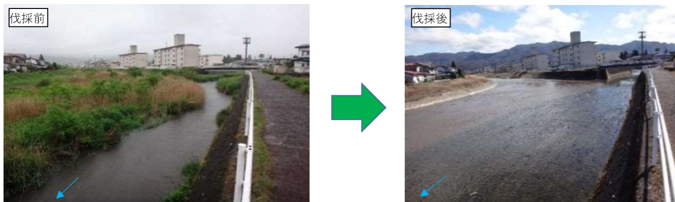
土砂掘削・伐採 イメージ
