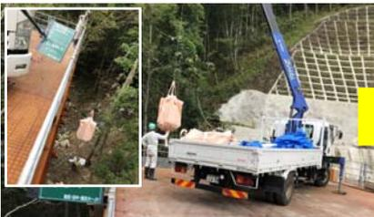
資材の搬入(ユニックで資材を下ろしモノレールで運搬)
