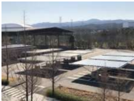
Jヴィレッジ カーポート型太陽光発電システム
