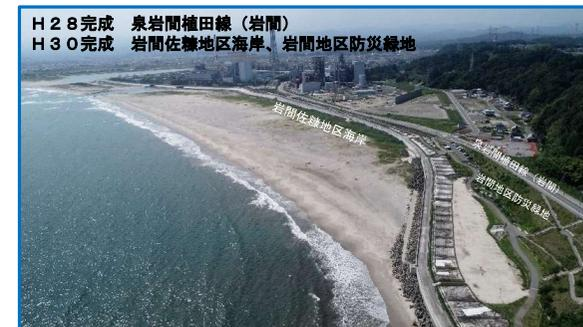
○海岸堤防の嵩上げ、防災緑地、道路など複数の手法を組み合わせた「多重防御」により、いわき市沿岸部の防災力が向上しました。
