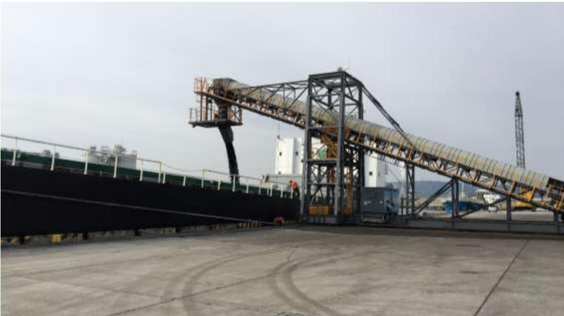
アスファルトで陥没を埋めて荷役機械を安定して設置できるようにしました。
