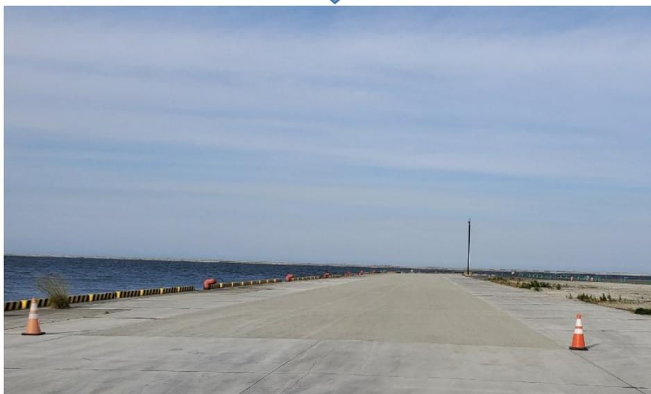
支障のある部分のコンクリート舗装を撤去、敷砂利工により仮復旧し、荷役作業ができるようになりました。
