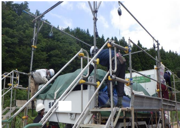
シートによる飛散・流出防止対策
