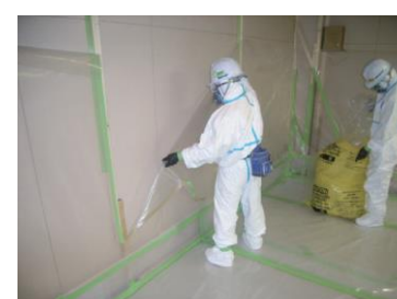
養生シートの撤去
