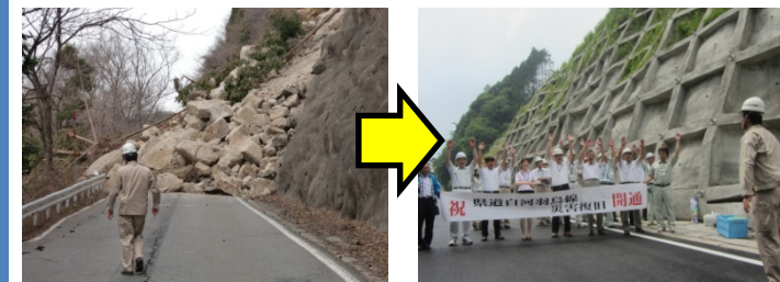
復旧状況(県道白河羽鳥線 西郷村)
