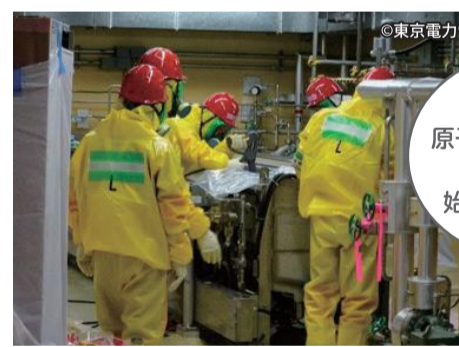
機器の汚染の除去作業(原子炉建屋内)
