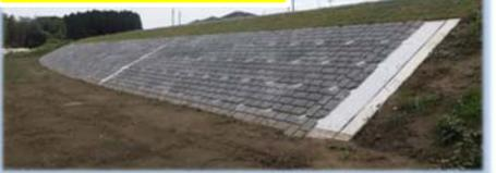
河川改修により、被災時流量(1,000m<sup>3</sup>/s)が流下可能
